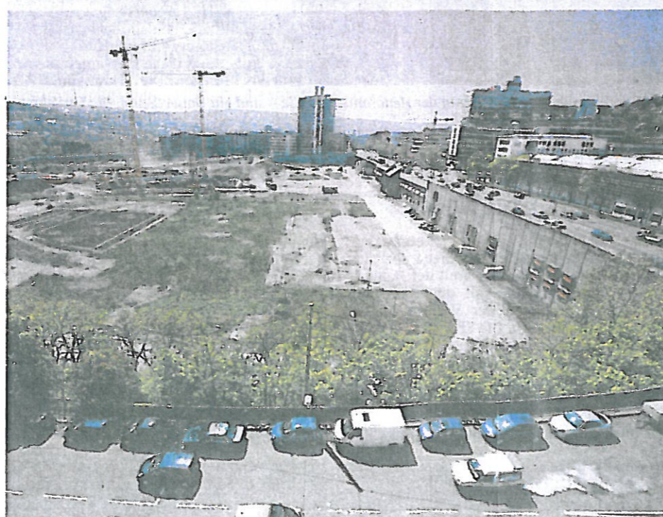
Während sich die Kräne für den Bau der neuen Stadtbibliothek hinter dem Hauptbahnhof schon
