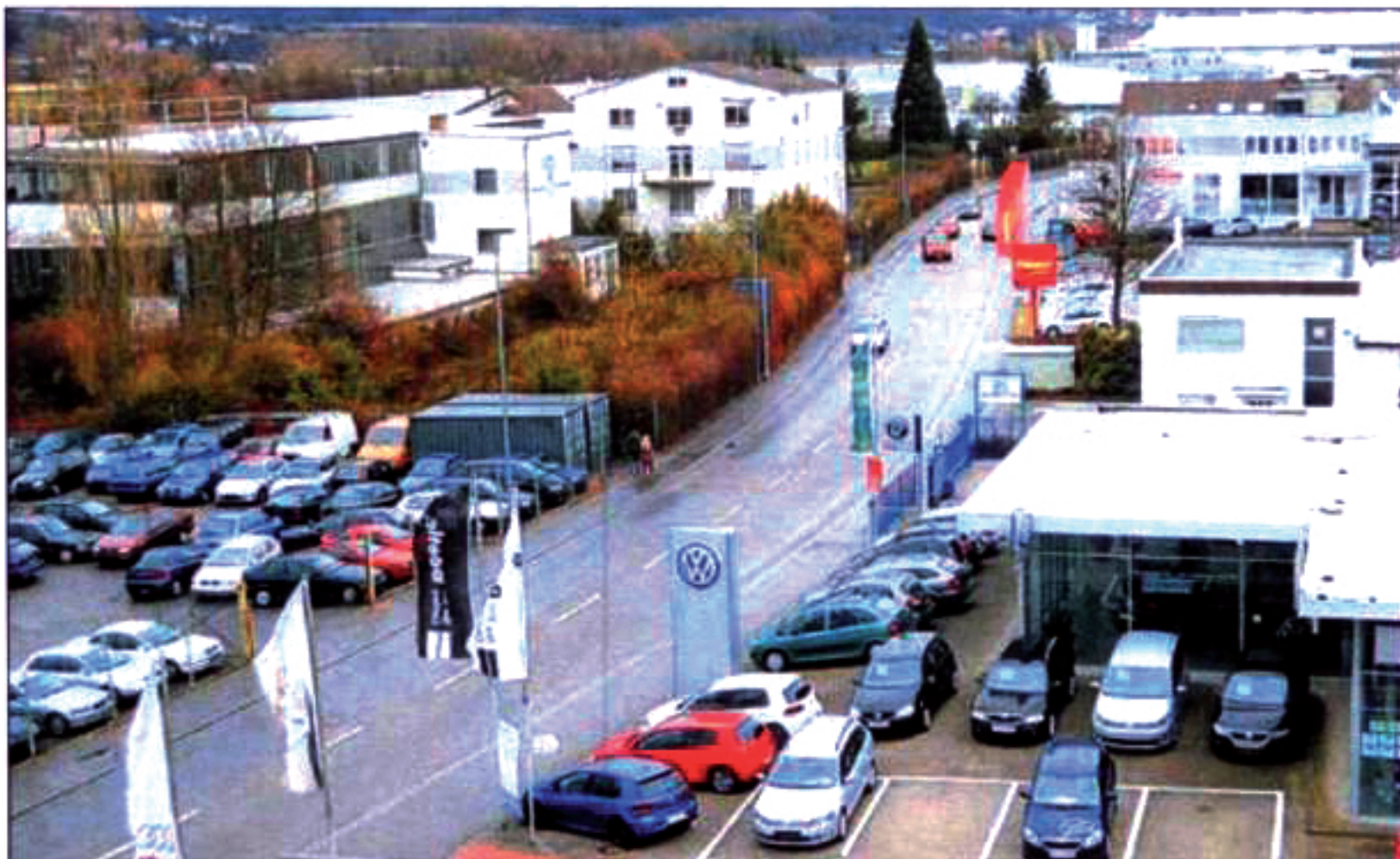
Bis zur Gutenbergstraße reicht die Teilfläche westliche Neulandstraße, in der Sondergebiet für großflächigen Einzelhandel ausgewiesen wird. Das gilt auch für das Areal der Firma Edel (links) auf dem die Firma Lidl ein „Kaufland“ erstellen will. Foto: Weis
