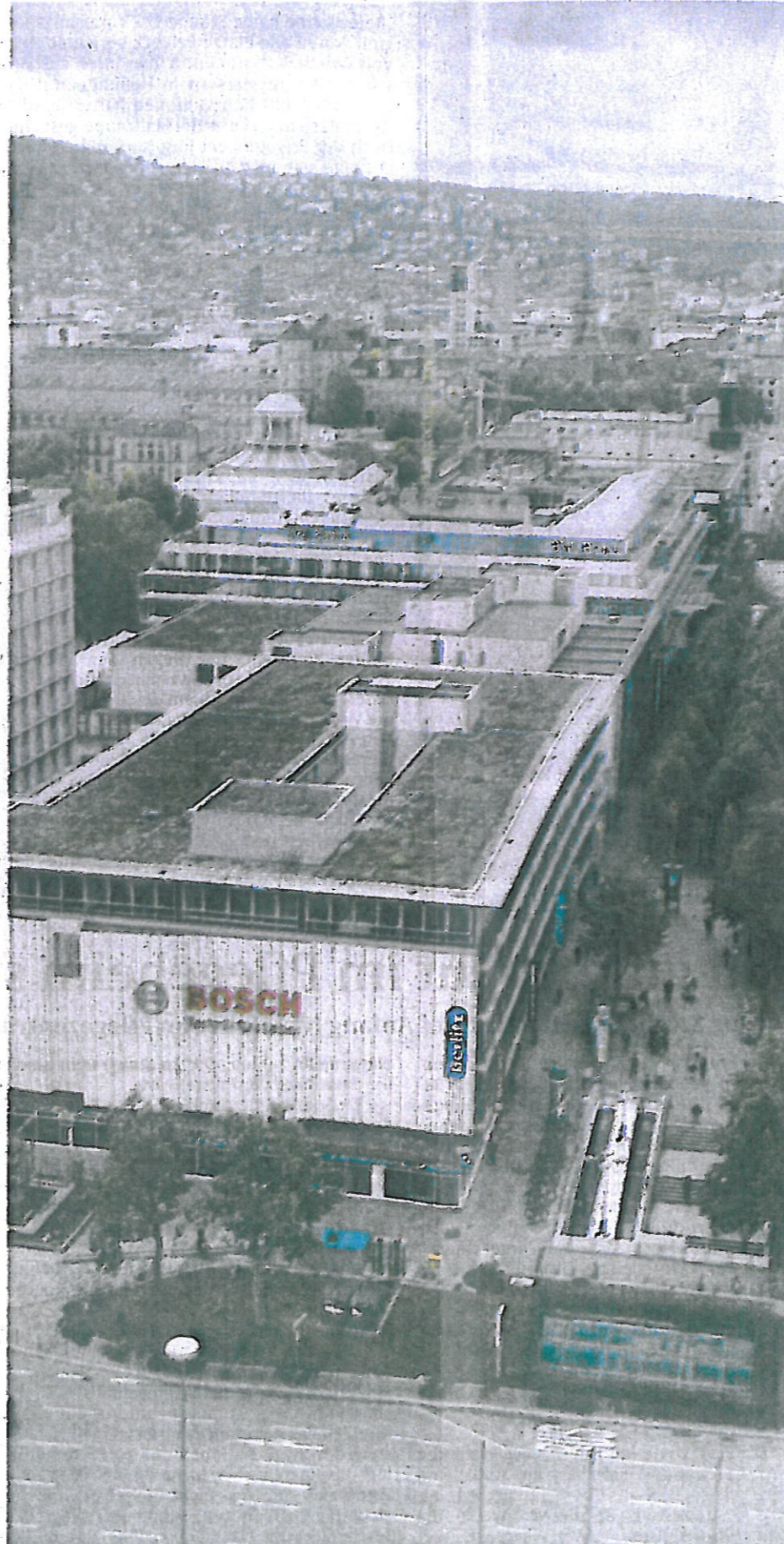
Der Schlossgartenbau-Komplex (vorne) und das BW-Bankgebäude beherrschen die halbe untere Königstraße. Kommt der Abriss oder nur eine Modernisierung? Fotos Achim Zwegarth
